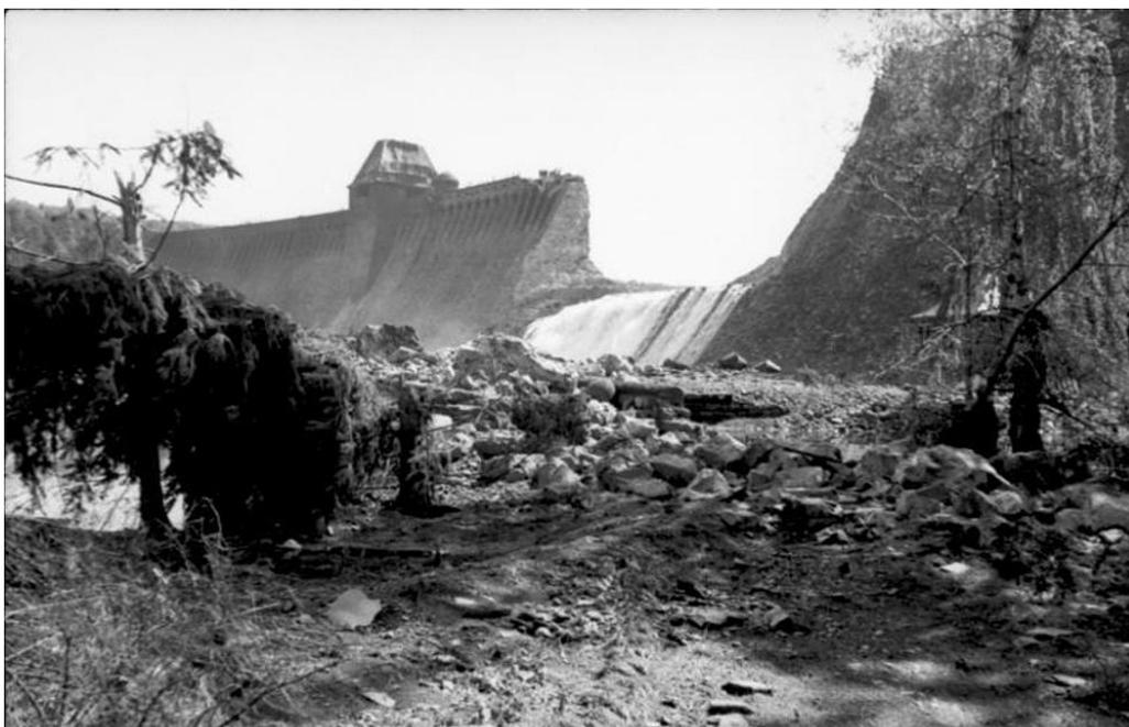
**Рис. 9.** Дамба Мён после бомбардировки английскими самолетами
