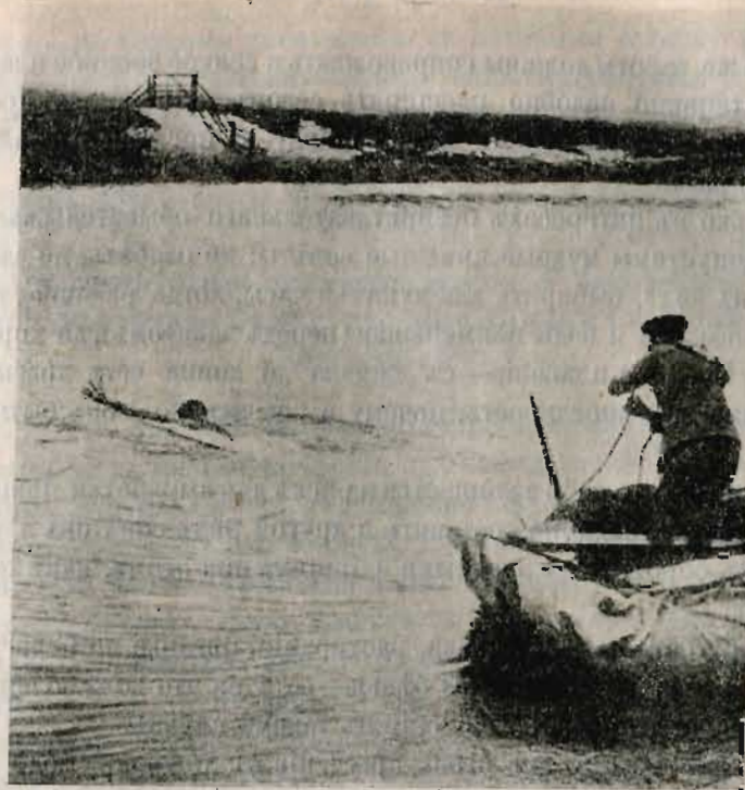
Перепосъ пловцомъ черезъ рѣку веревки отъ конца паромнаго каната.
