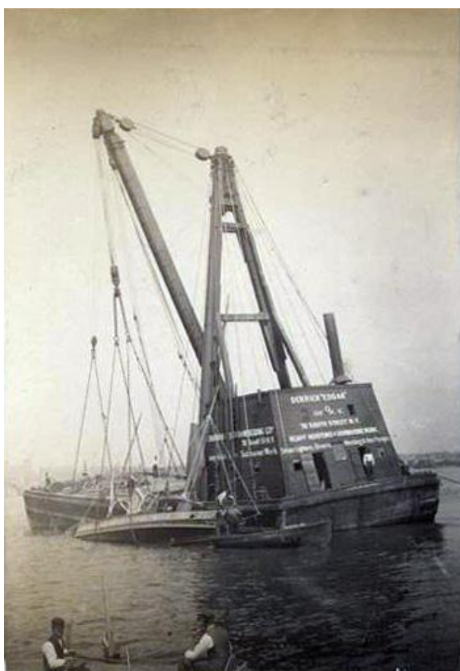
Рис. 7. Кран «Edgar» поднимает яхту «Aztec». Рядом видны люди на двух шлюпках (Merritt-Chapman & Scott Corporation № 2008.28.2.31)
