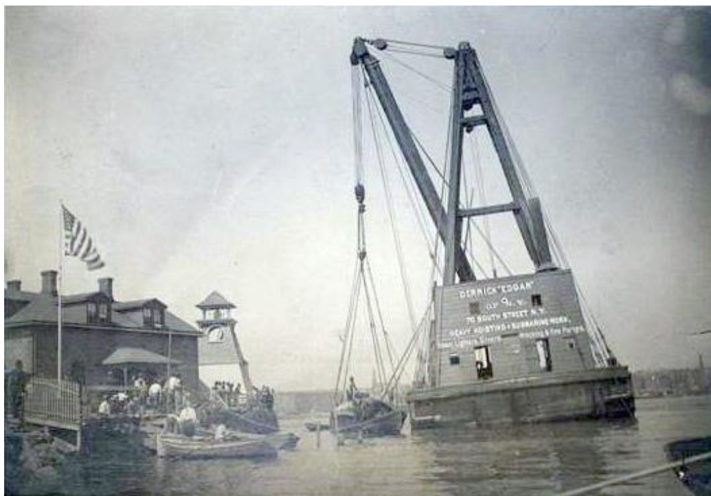
Рис. 6. Вид в корму крана «Edgar», поднимающего «Aztec». Слева видна толпа зевак у маяка Хелл Гейт (Merritt-Chapman & Scott Corporation № 2008.28.2.33)
