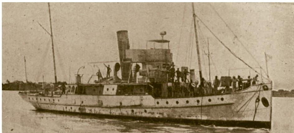
Рис. 2. Парагвайская канонерская лодка «Тасуаги» постройки 1907 г. (водоизмещение 366 т, основные размеры 39,38 x 7,32 x 1,83 м, скорость 10 узлов, экипаж 55 человек, вооружение по две 76-мм и 37-мм пушки), самый мощный боевой корабль ВМФ этой страны до 1931 года.
