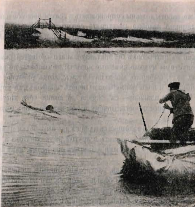
Переносъ пловцомъ черезъ рѣку веревки отъ конца паромнаго каната.
