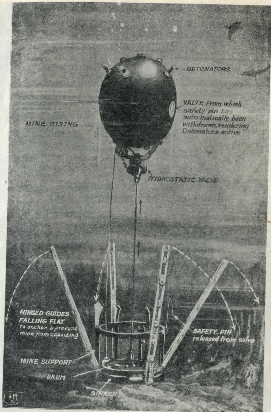
Германская мина заграждения, выбрасываемая подводною лодкою.
